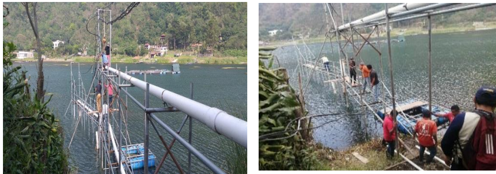
Ampliación de muelle.
