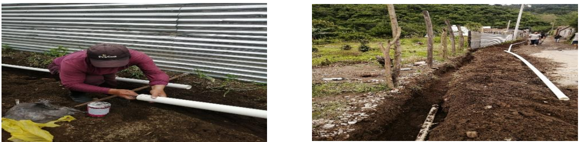
Ampliación de tubería.
