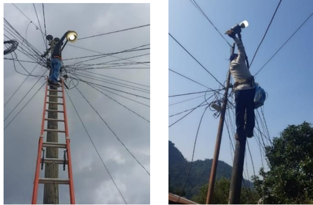
Reparaciones y mantenimientos a la red de alumbrado público en el municipio.
