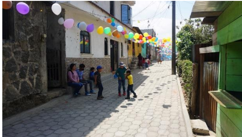
Proyecto: Mejoramiento Calle del Padre Pancho, Colonia San Gregorio (Adoquinado) San Lucas Tolimán, Sololá
