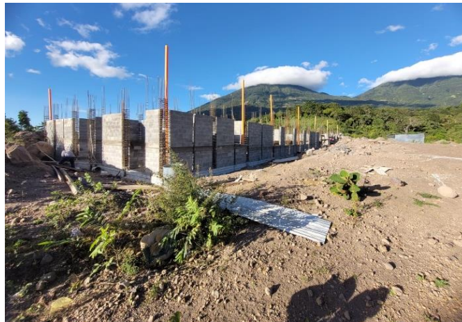
Avance del proyecto: Construcción Centro de Atención Integral Materno Infantil (CAIMI) Cabecera Municipal San Lucas Tolimán, Sololá
